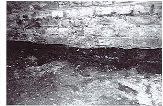
Abb. 4: überbaute Fundamente des Massivbaues
